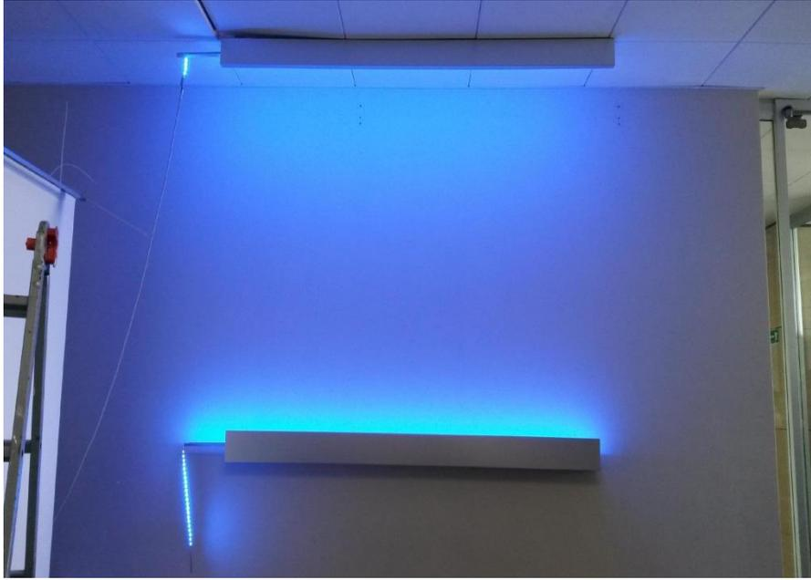
FIGURA 75 - ASPETTO DELL'INSTALLAZIONE ULTIMATA E CON GLI STRIP LED ACCESO
