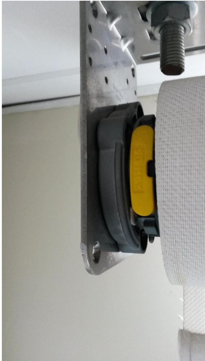
FIGURA 79 - MOTORE PER TENDA DOTATO DI FINE CORSA, OVVERO DI UN MECCANISMO IN GRADO DI RILEVARE L'ARROTOLOAMENTO MASSIMO DELLA TENDA E FERMARE IL MOTORE
